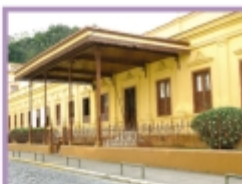
Colégio Nossa Senhora das Dores Nova Friburgo - RJ
