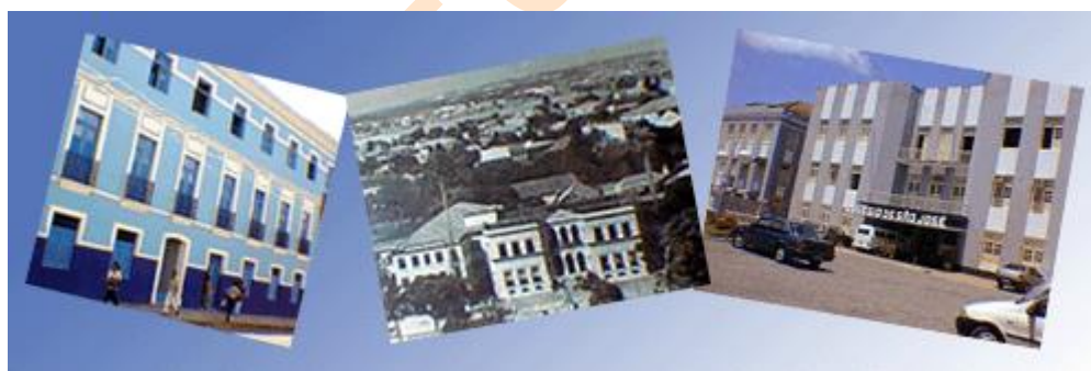
FIGURA 11: Colégio São José (Recife) – no centro o prédio original, que existe até hoje.
